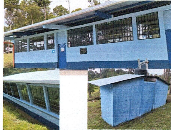
Foto 4: ÁREA DONDE SE MEJORÓ E INSTALÓ BALCONES. ASIMISMO SE COLOCÓ CUBIERTA DE LÁMINAS EN LOS SANITARIOS Y SE PINTÓ TODO EL MÓDULO DEL CENTRO EDUCATIVO FINALIZADO.
